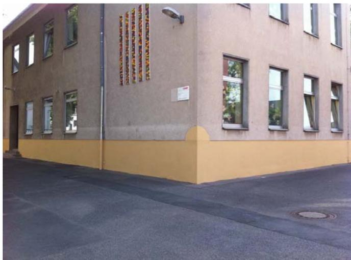
*Durch die Malerfirma Rath perfekt renovierte und grundierte Sockelzone*
